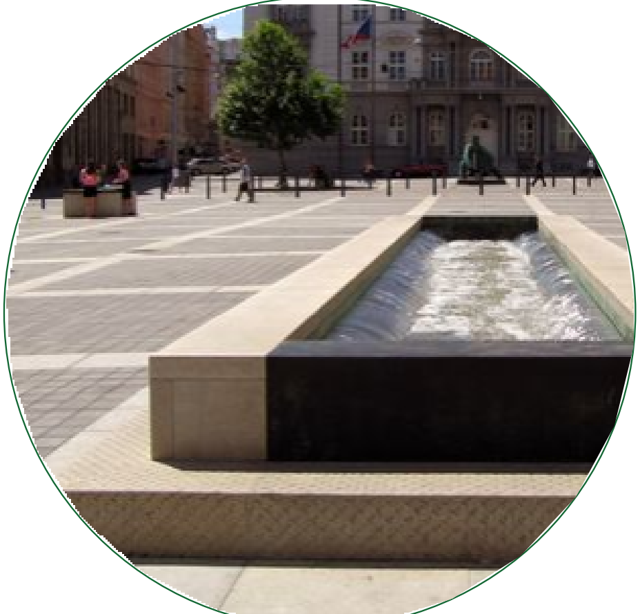
FONTANA LINEARE Fontana con funzione di vasca di prima pioggia e sedute perimetrali. Nella stagione estiva contribuisce alla riduzione dell'isola di calore
